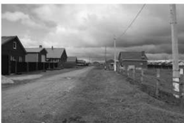
Илл. 6. Объект: «Техническое перевооружение сети газоснабжения Старовоскоцкого района. Технологическое присоединение к газораспределительной сети 18-ти жилых домов, расположенных в с.п. Узюково, ул. Северная. Газопровод высокого давления 1 кат. от существующего г/д в/д d=100мм, проложенному от ГК-2 до ГРП1-143 с Узюково, ШПРП, газопровод низкого давления на территории муниципального района Старовоскоцкий Самарской области. Вид с юго-востока на участок обследования.
