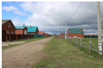
Илл. 5. Объект: «Техническое перевооружение сети газоснабжения Старовоспольского района. Технологическое присоединение к газораспределительной сети 18-ти жилых домов, расположенных в с.п. Узюково, ул. Северная. Газопровод высокого давления 1 кат. от существующего г/да в/д d=100мм, продолженному от ГК-2 до ГРП-143 с. Узюково, ШПРП, газопровод низкого давления» на территории муниципального района Старовоспольский Самарской области. Вид с юго-востока на участок обследования.
